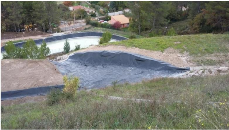
*Etanchéification du réseau EP par géo-membrane*
