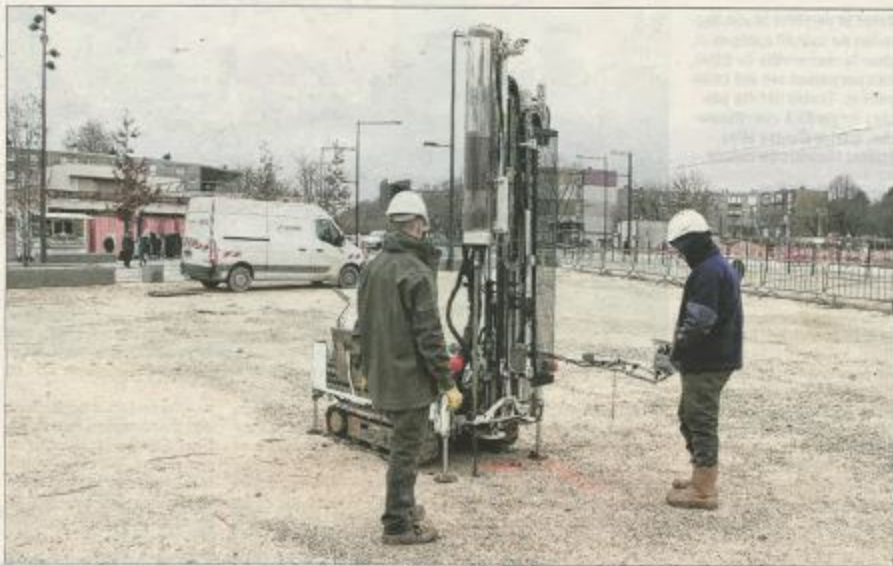
Le bureau d'études Géotec opérant ici des prélèvements nécessaires à une étude de sol sur le site d'une future brasserie, à Quetigny. Photo archives (BP) Jean-François DUMAND
